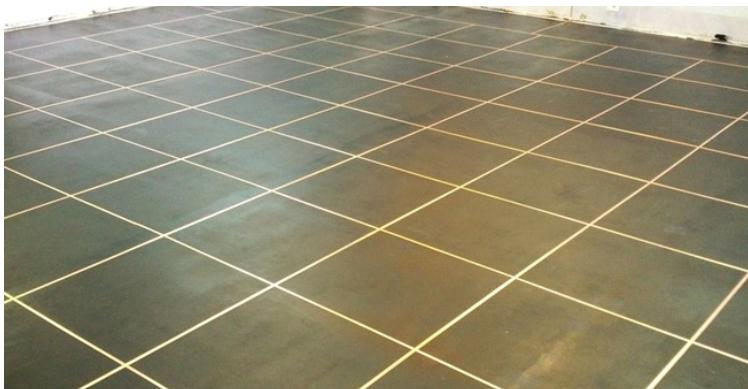
Самоклеящуюся медную ленту необходимо клеить по огрунтованной поверхности после окончания процесса полимеризации грунтовочного состава LINCRETE® P100. Лента клеится по контуру помещения (на расстоянии не более 0,1 м от стены или края помещения) и далее по поверхности с шагом (клетками) 1,5 – 3,0 м (в зависимости от конфигурации помещения).
